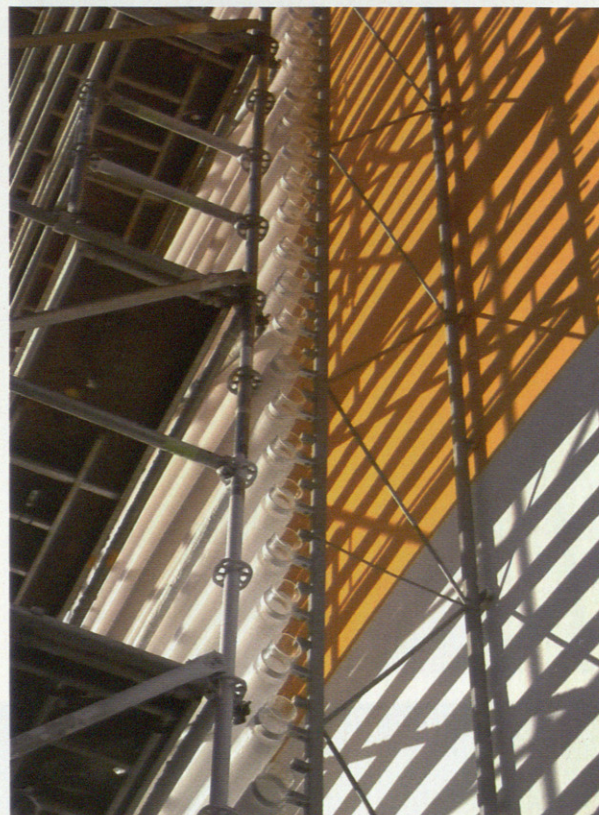
SISTEMA DE ANCLAJE DE LOS TUBOS DE METACRILATO
